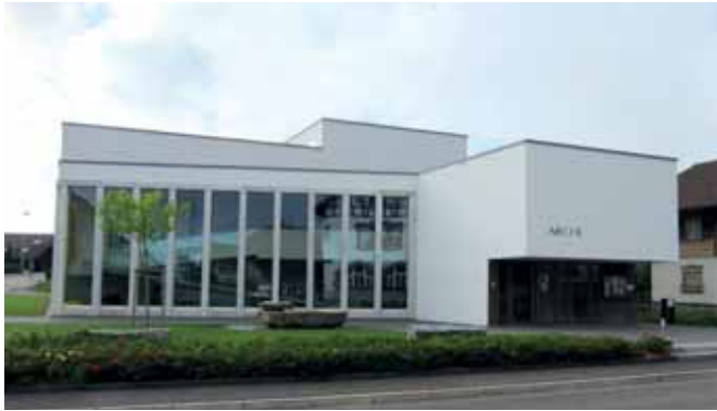
Le nouveau lieu de culte de l'Église réformée à Bösinggen (© 2011 J.-F. Mayer).
